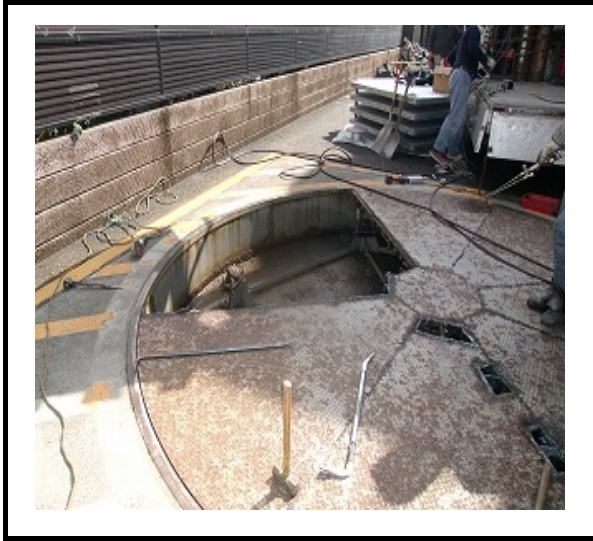
④解体・撤去作業
