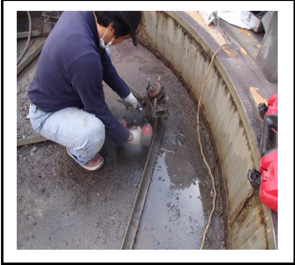
⑦解体・撤去作業
