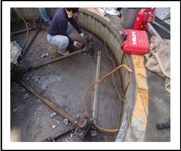
⑧解体作業
