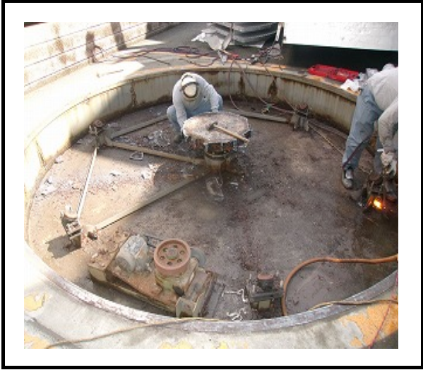
⑨解体作業
