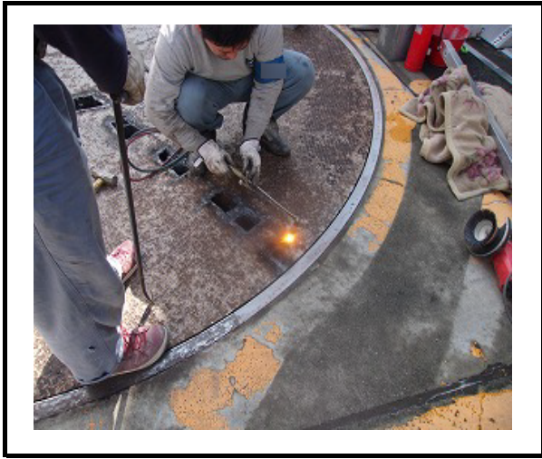
②解体・撤去作業
