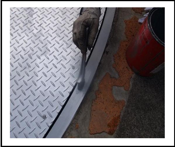
② 錆部補修、塗装作業
