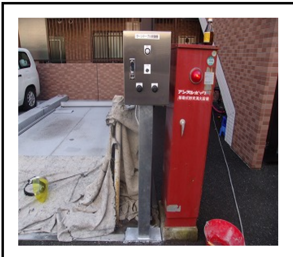
③操作盤交換作業
