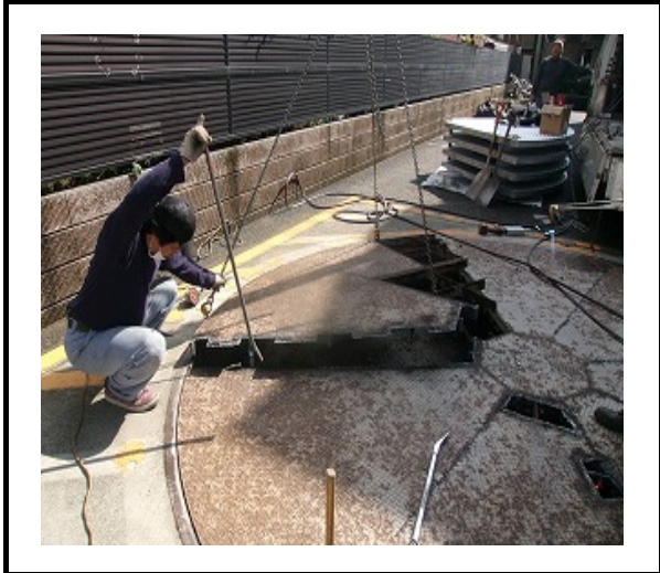
③解体・撤去作業
