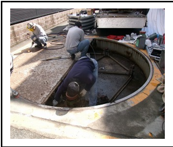
⑤解体・撤去作業
