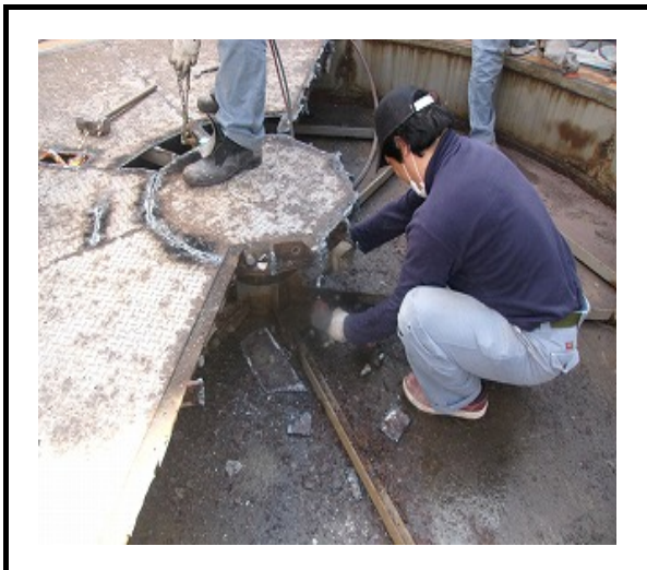
⑥解体・撤去作業
