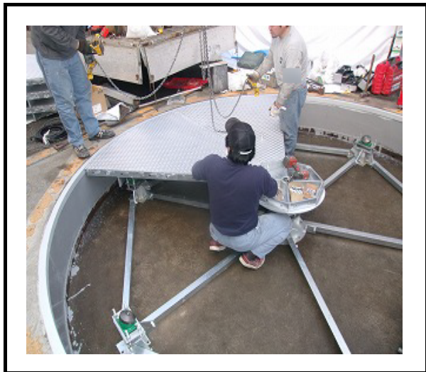
⑥設置作業
