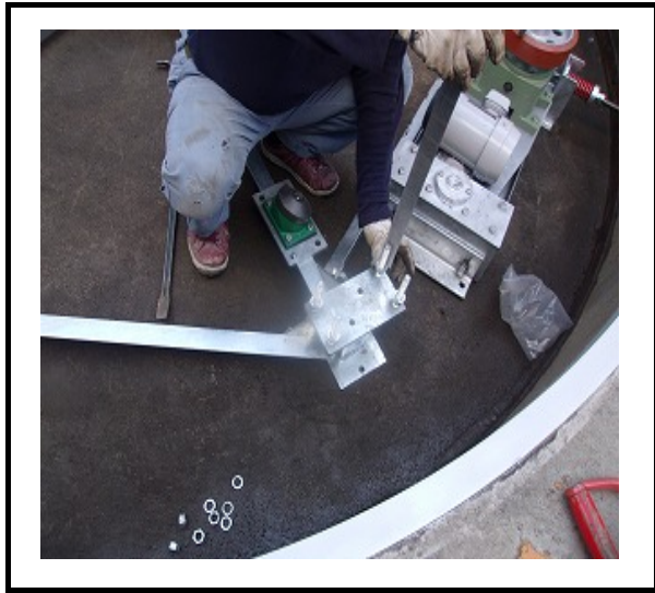
④設置作業
